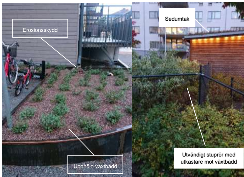
Figur 9. Tv: Exempelbild på upphöjd växtbädd som tar upp takvatten från utvändigt stuprör. Erosionsskydd i form av större stenar vid stuprörets utkastare. Th: Förrådskast försett med sedum och utvändigt stuprör med utkastare som leder vatten mot växtbädd på gården (Foto Bjerking AB).
