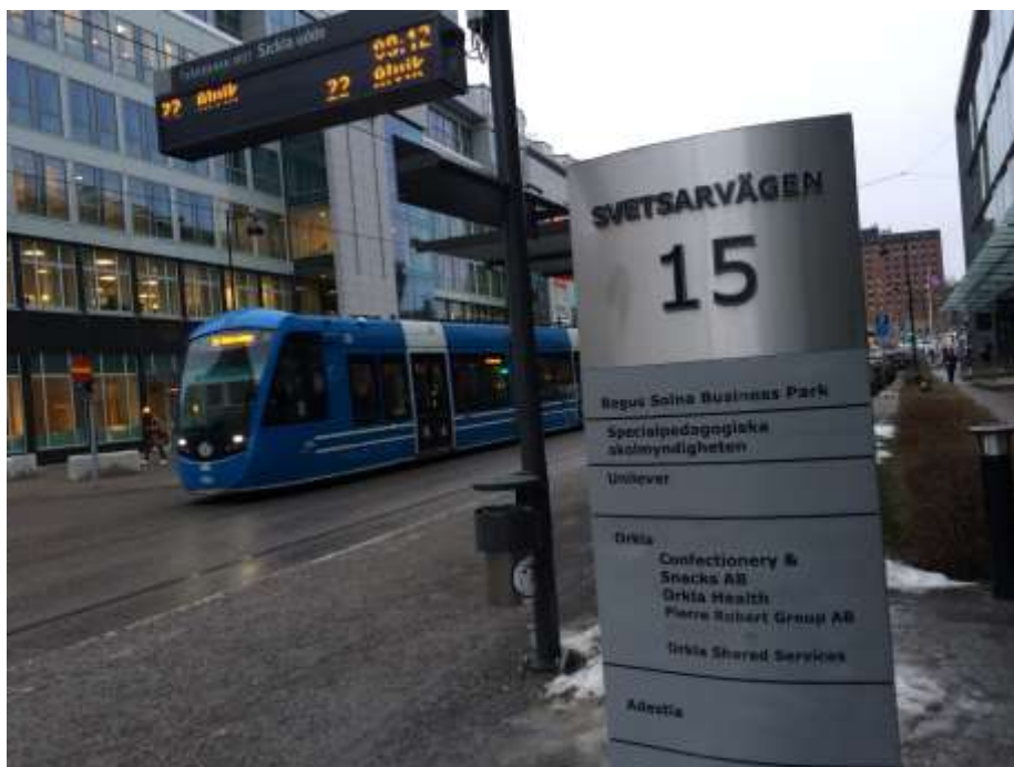
Figur 2.16. Svetsarvägen i Solna har ett gaturum på ungefär 28 meter fasad till fasad. Här går Tvärbanan med två spår. Det finns kantstensparkering på ena sidan gatan, mycket breda trottoarytor men ej cykelbana.
