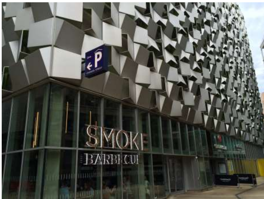
Figur 2.19. Exempel på parkeringshus med levande gatuplan, restaurangen Smoke i Sheffield.
