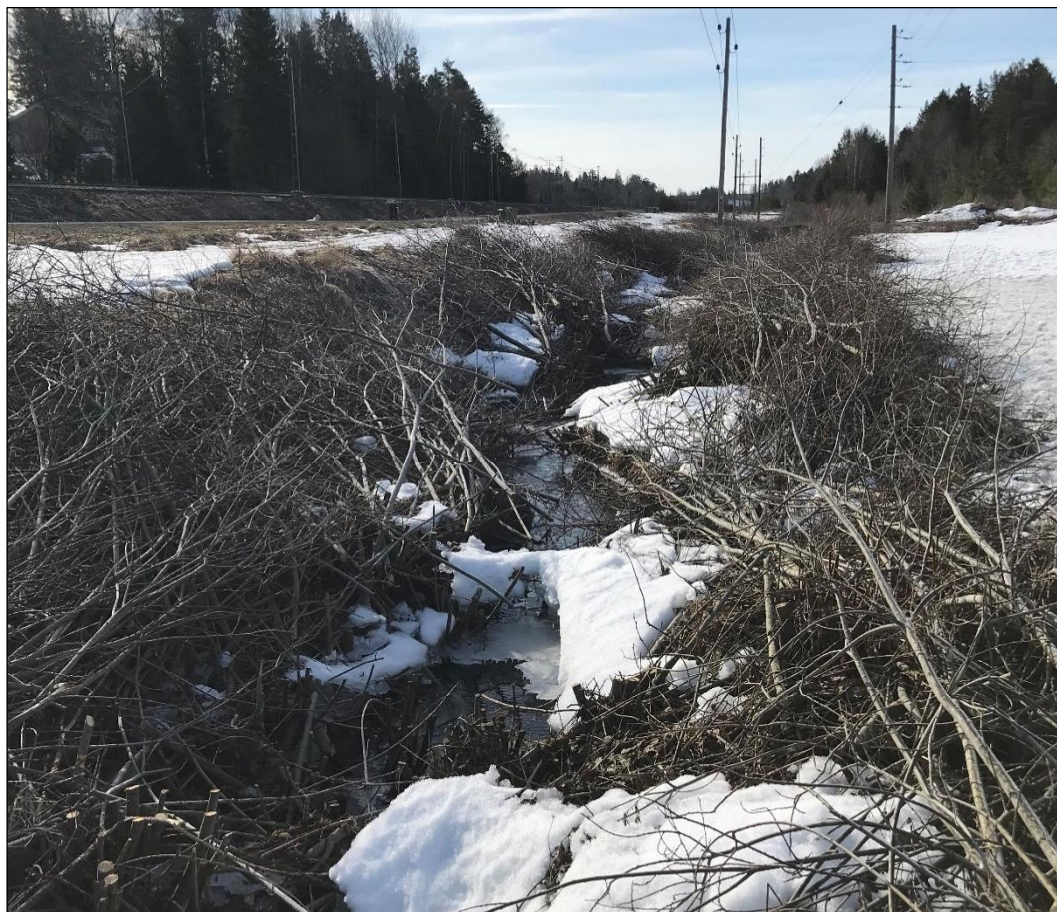
Figur 10. Avverkning av sly som sedan har lämnats kvar i vattendragsfåran. Grenarna som ligger kvar i vattendragsfåran utgör ett stort motstånd mot vattenflödet. Grenarna minskar därtill vattendragets kapacitet och kan orsaka uppdämning. Foto: Lisa Carlsson, 2018-04-03.
