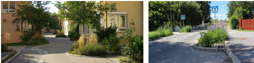
Figur 18. Regnbäddar: t.v. Arkadien Asperg, Stuttgart, Tyskland (Foto: Atelier Dreiseitl), t.h. Öringevägen, Tyresö kommun, Stockholm
