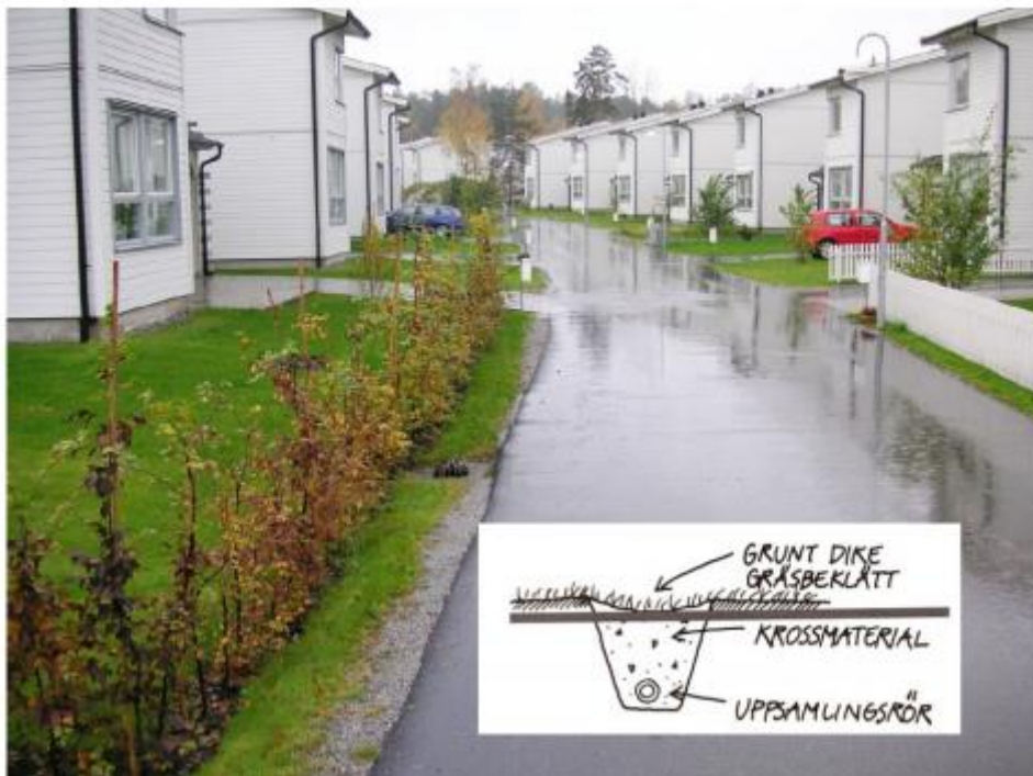
Figur 7: Ett långsmalt infiltrationsstråk gömmer sig under gräset mellan gatans stödremsa och den nyplanterade häcken.
